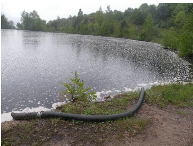
Obr. Gudróny v Kameňolome Srdce v Devínskej Novej Vsi pred sanáciou
